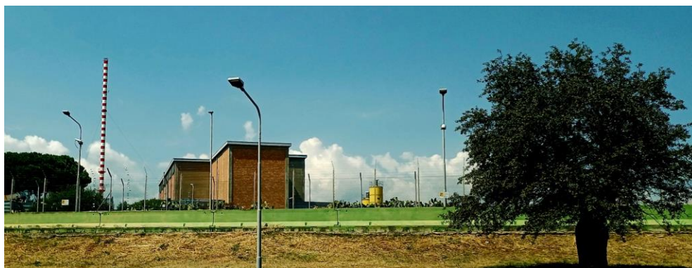
Impianto Nucleare Itrec c\o Centro Enea Rotondella
